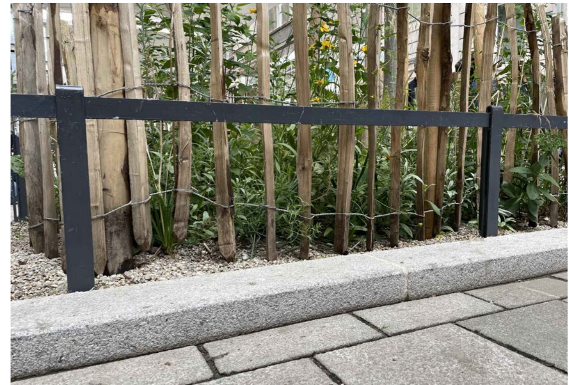
FOTOGRAFIE: Příklad řešení výsadby stromů v historickém centru města Vídně. Řešení navržené pro výsadby v ulici Orlí oproti fotografii neobsahuje: - zvýšený obrubník (aby nezamezoval vtoku vody do rabata) - nadzemní kotvení dřevěnými kůly - dočasnou ochranu trvalek dřevěným plůtkem
